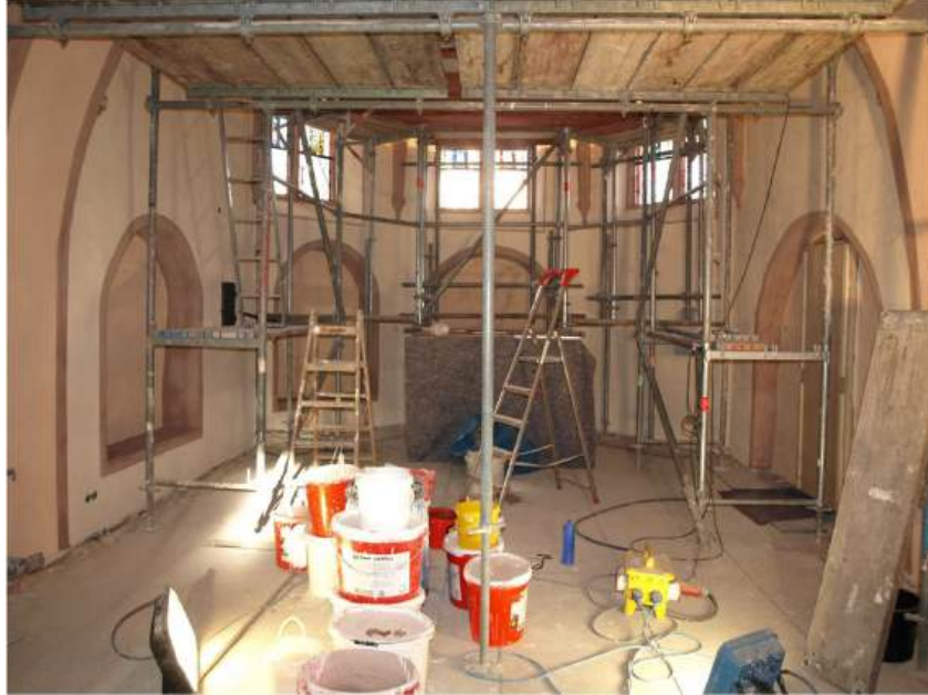
Innenrenovierung 2014 – Arbeiten im Chorraum der Kirche
